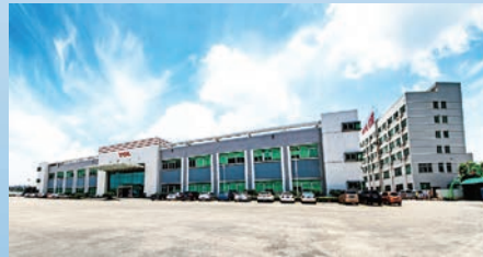
Jiujiang Base (2 εκ. σετ κλιματιστικών)
